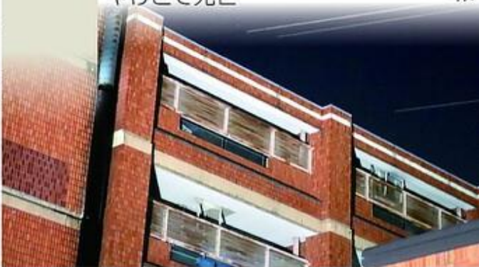
現場のマンション
